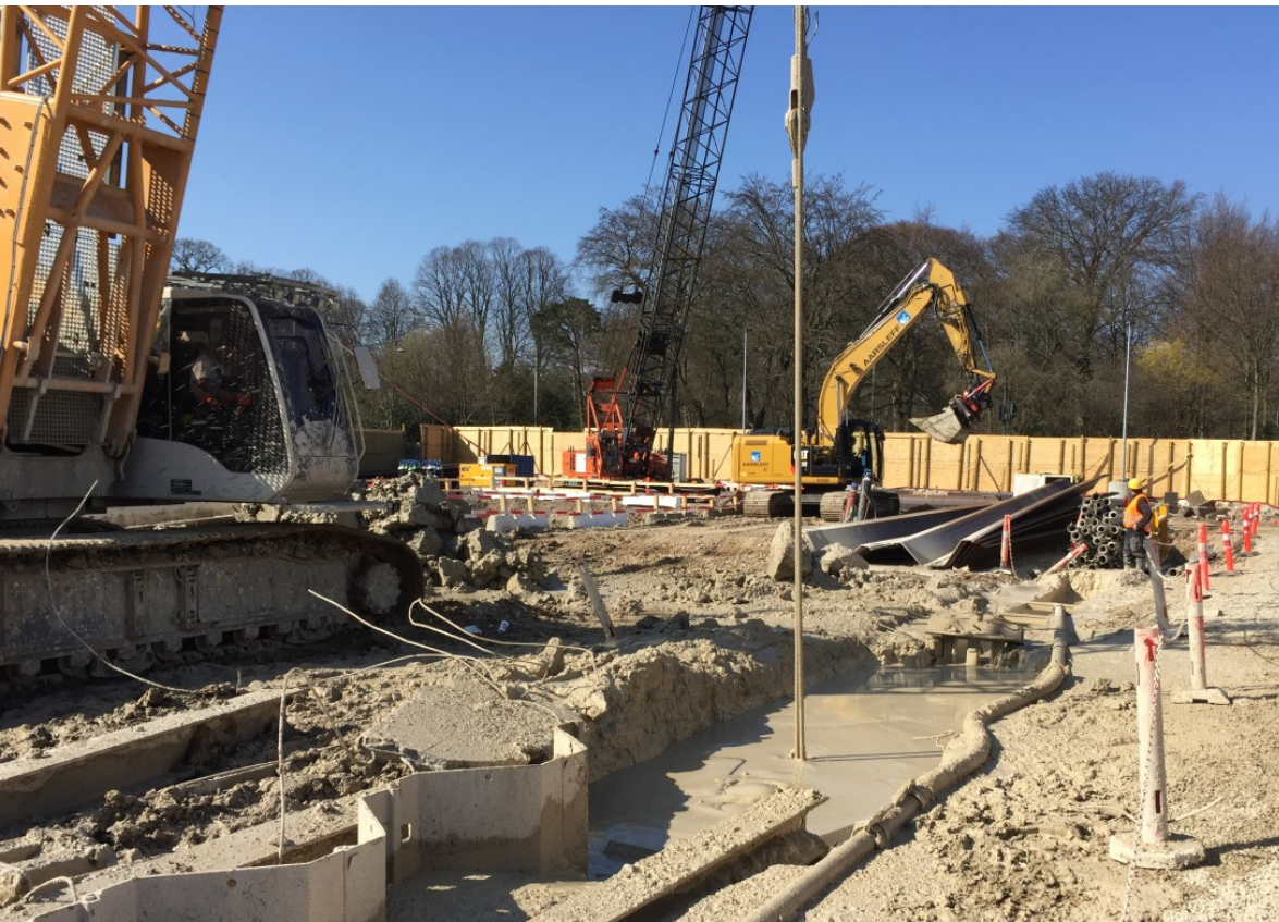
Flere store gravehindringer har her medført at ledevæggen er gået i stykker.
